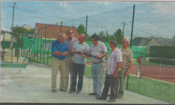
RÉUNION. Les élus s'entretiennent sur l'évolution du chantier qui jouxte l'autre terrain.
